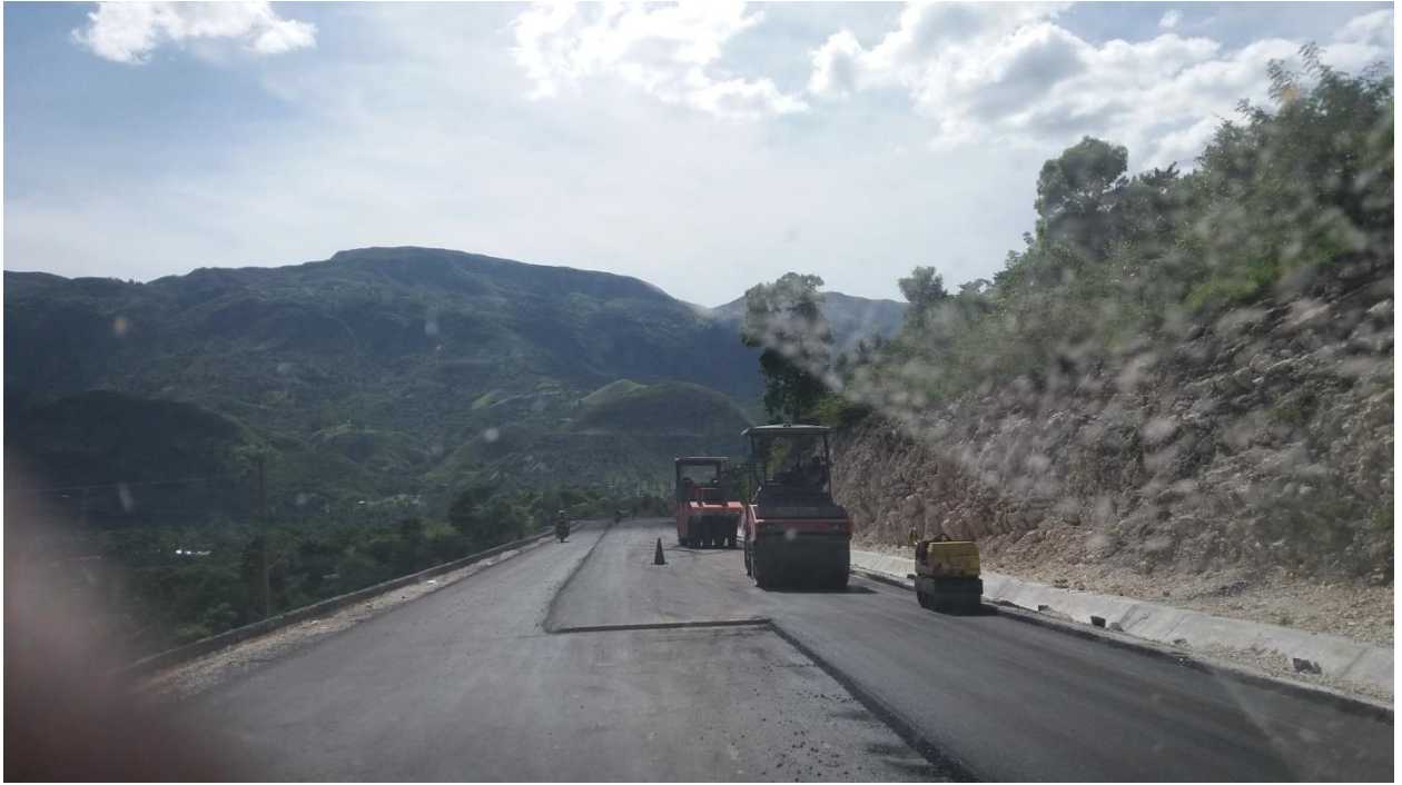
Travaux de réhabilitation de la route Ennery-Cap-Haitien.
