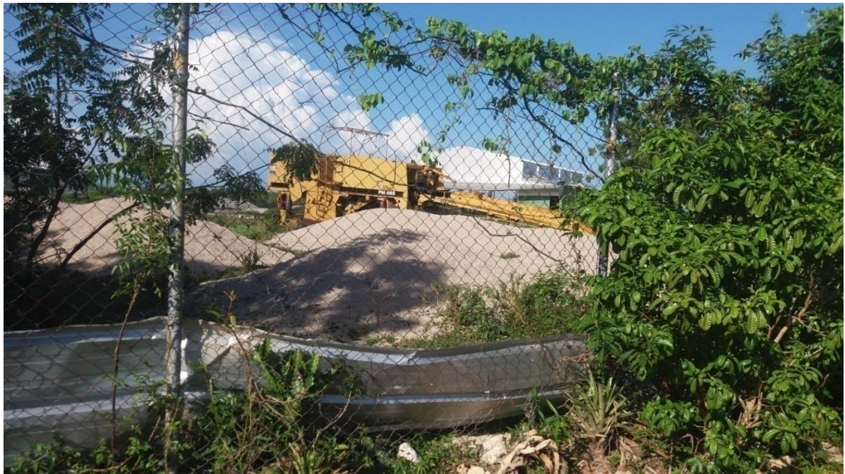
Matériaux restants sur le site
