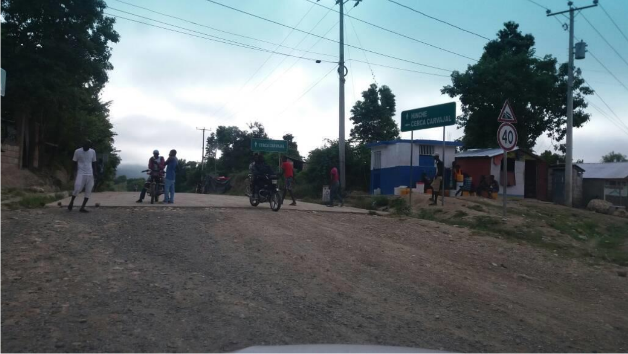
Début de la route Coladère Cerca-Cajavajal
