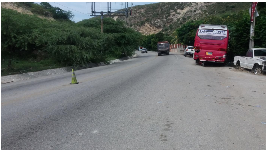
Réhabilitation du tronçon de route Saint-Marc/Gonaïves
