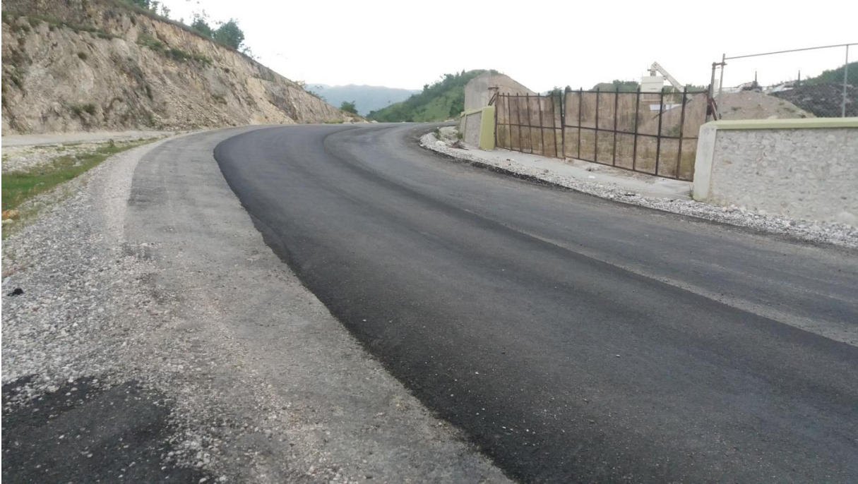
Bétonnage de la route Kans Camp-Perrin en cours
