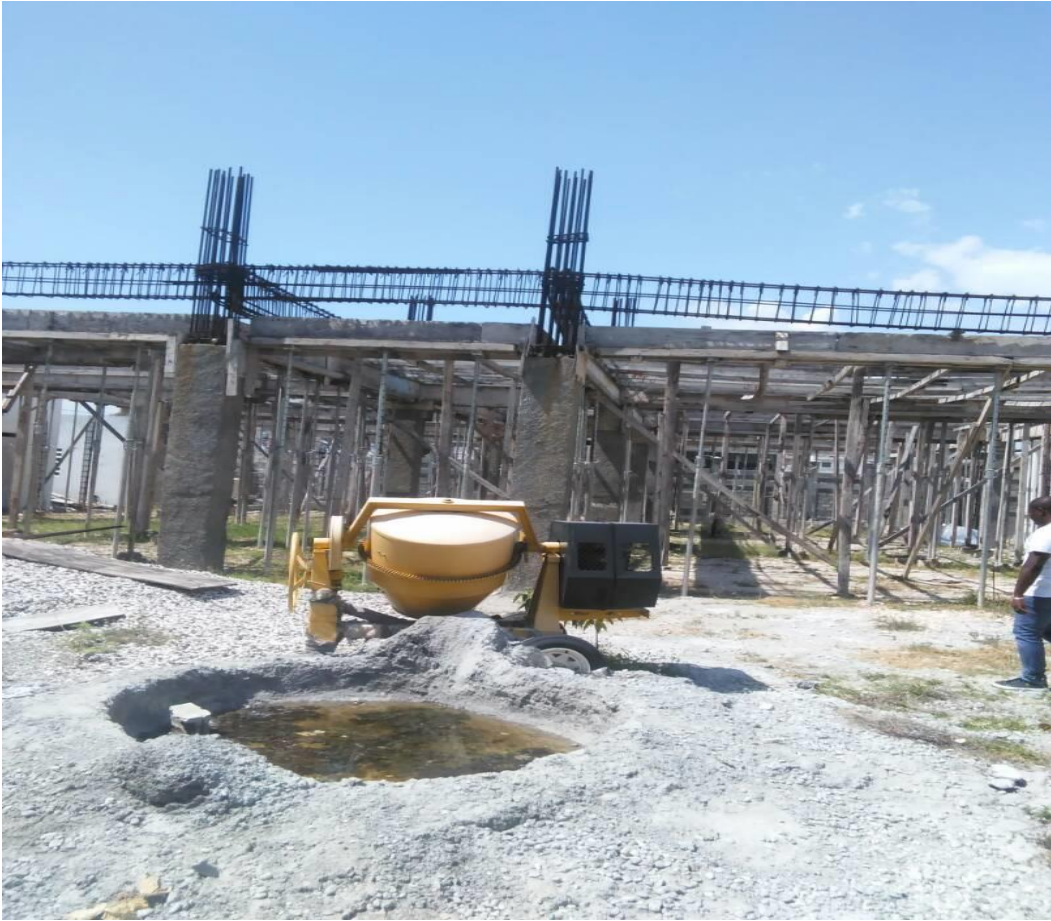
Partie inachevée du lycée Toussaint Louverture
