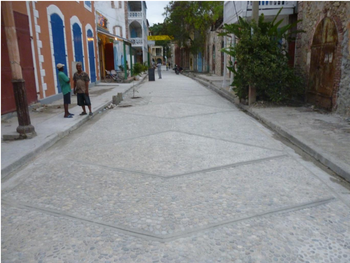
La rue du Commerce transformée en rue piétonne
