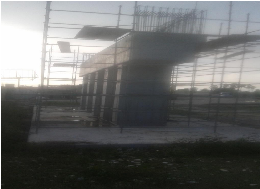
Structure de base du Viaduc de la Marine Haïtienne
