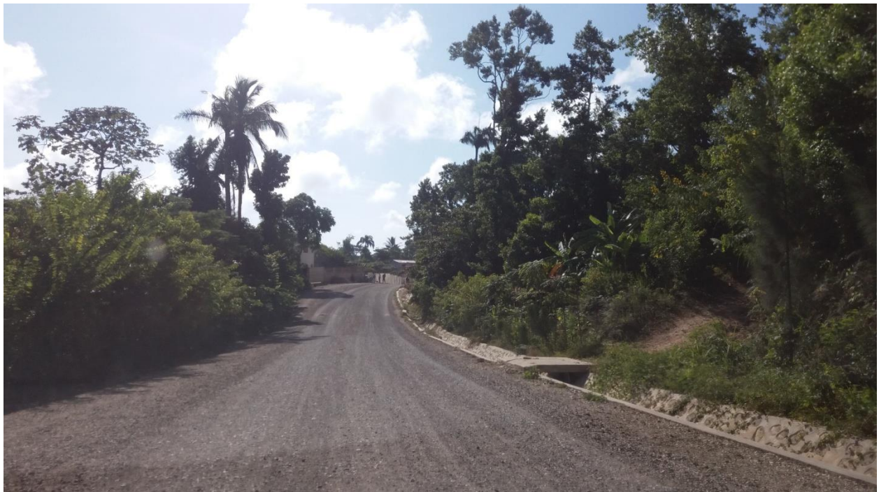
Une section des tronçons non bétonnées
