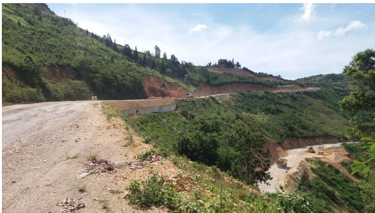
Travaux de terrassement du tronçon Ennery-Cap-Haitien, Pulboreau versant Nord.
