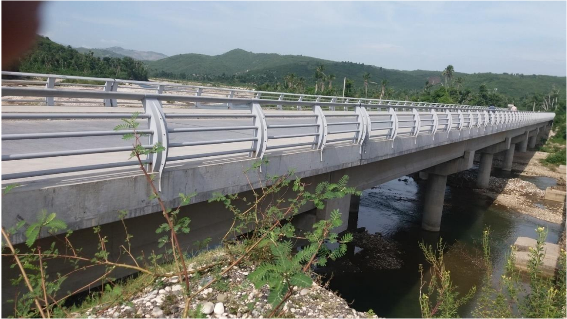
Pont Voldroque de profil
