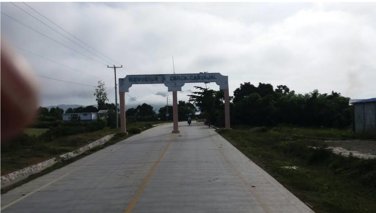
Route de Cerca-Cavajal en béton hydraulique
