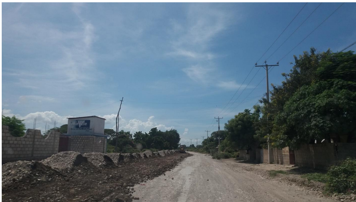
Travaux sur la route de Port-de-Paix
