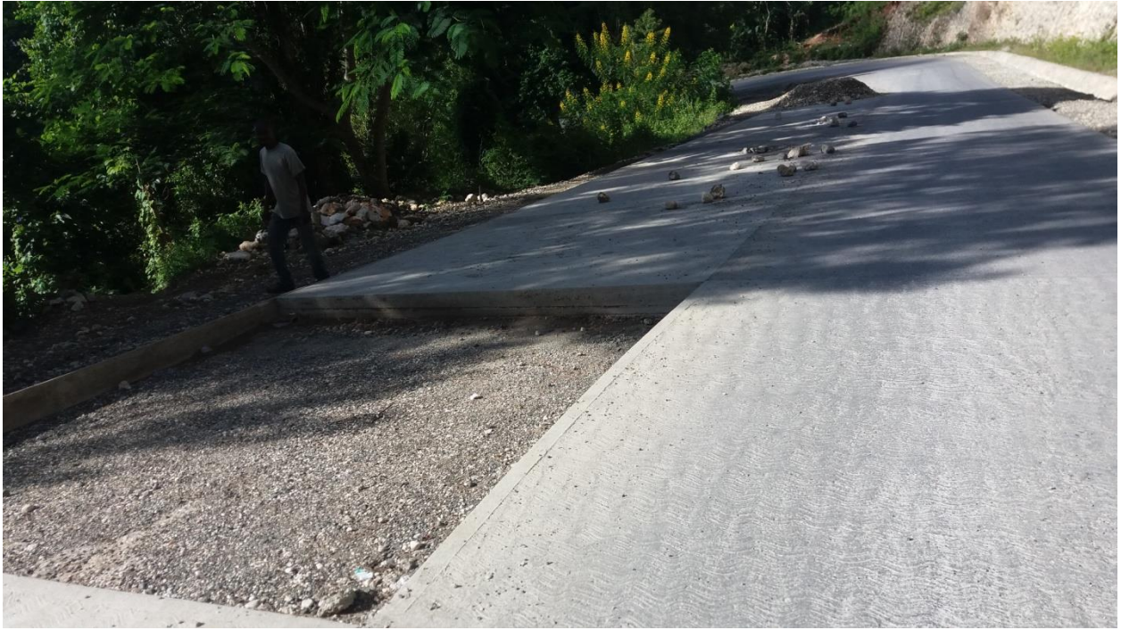
Béton hydraulique inachevé
