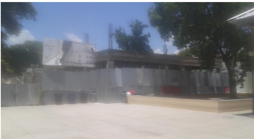
Partie inachevée du lycée
