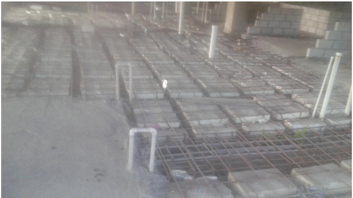
Ferrailage du parquet
