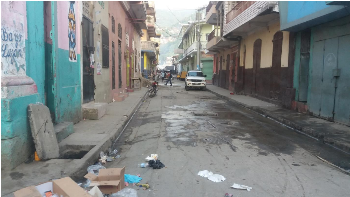
Etat de réhabilitation des rues du Cap-Haitien
