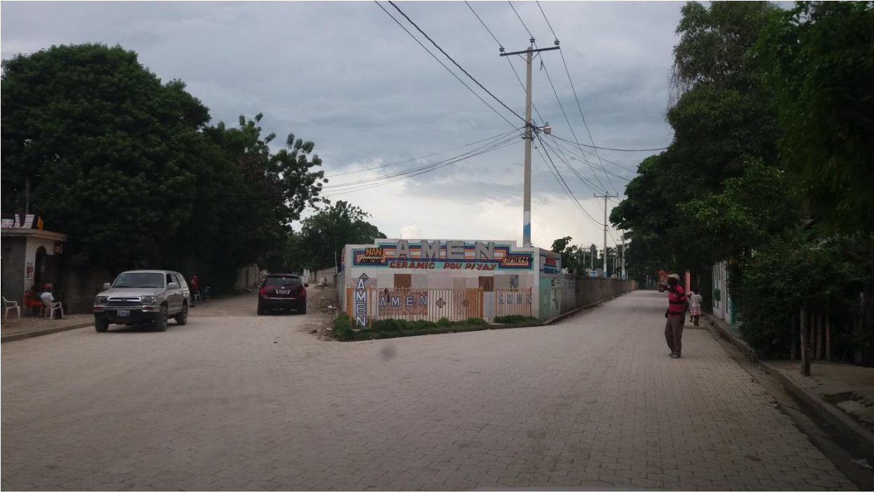
Zone adoquinée du centre-ville de Hinche
