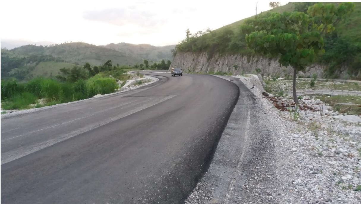
Bétonnage de la route Kans Camp-Perrin en cours 2
