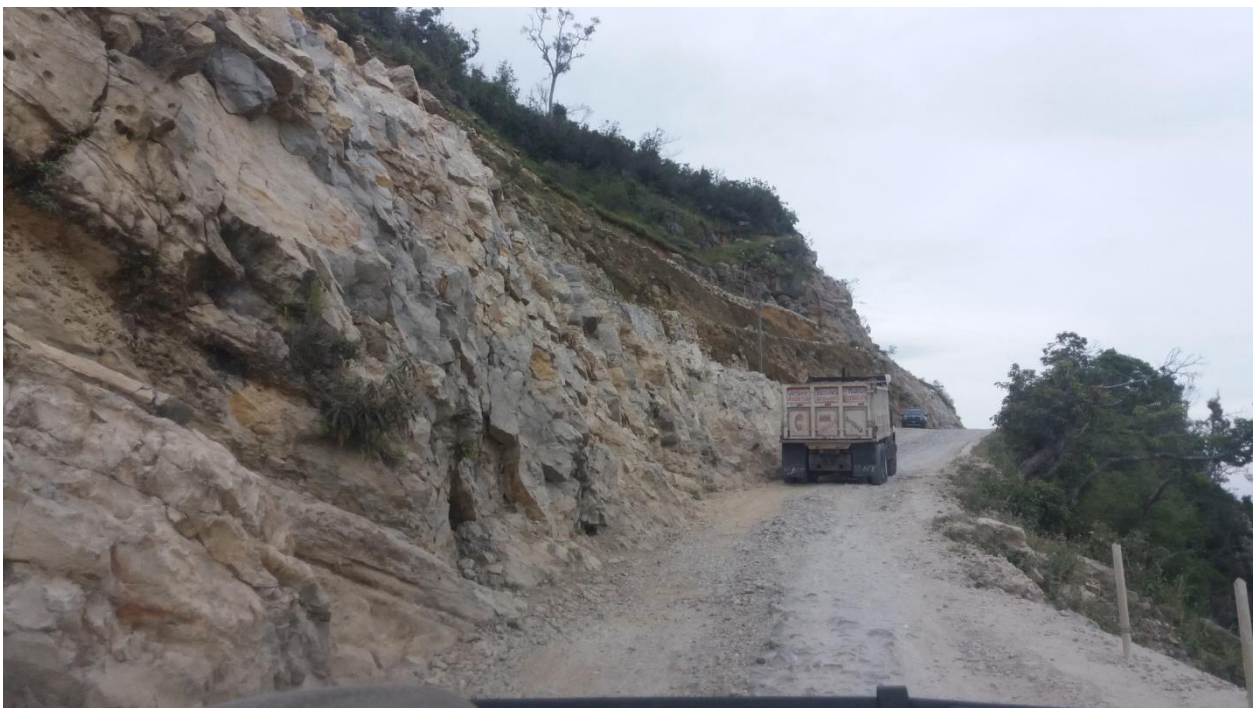
Le terrassement (Fanm Pa Dra)
