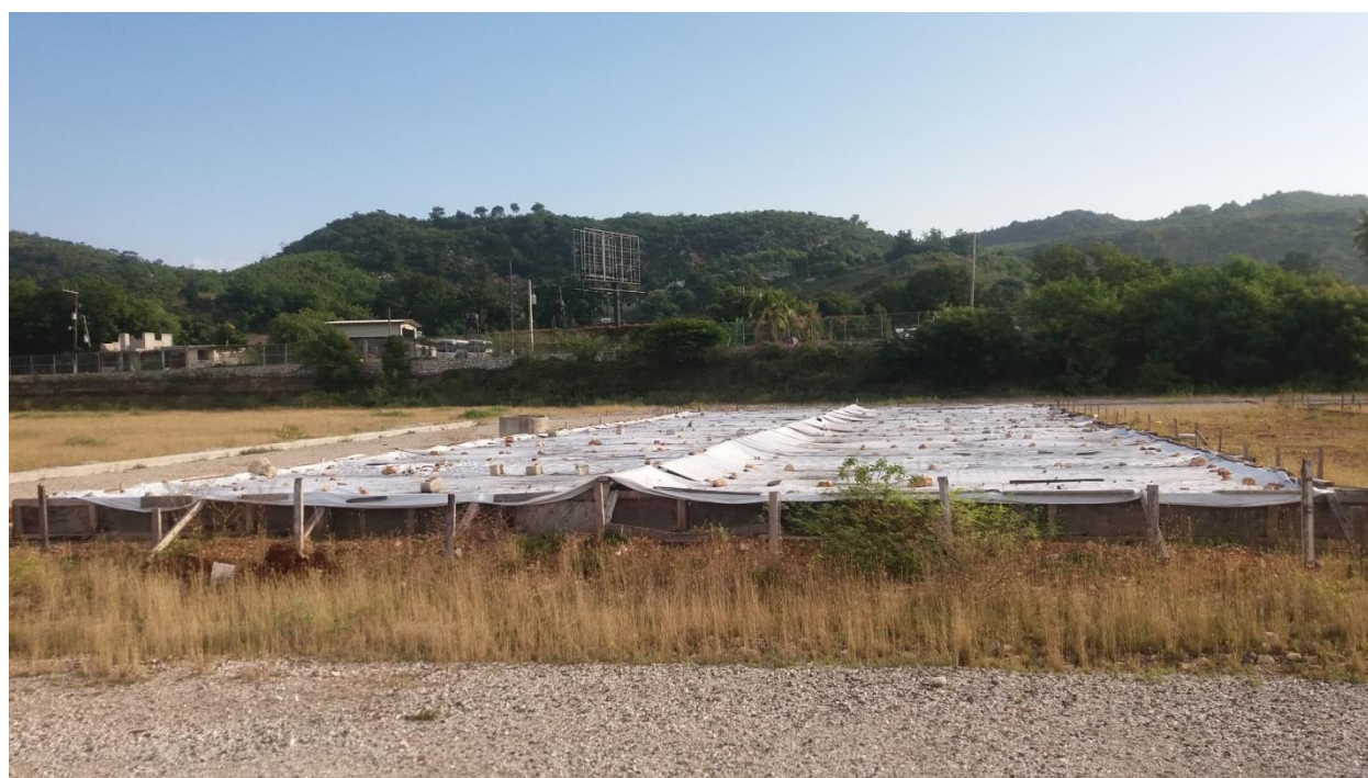
Parquet ferrillé et couvert pour éviter la rouille
