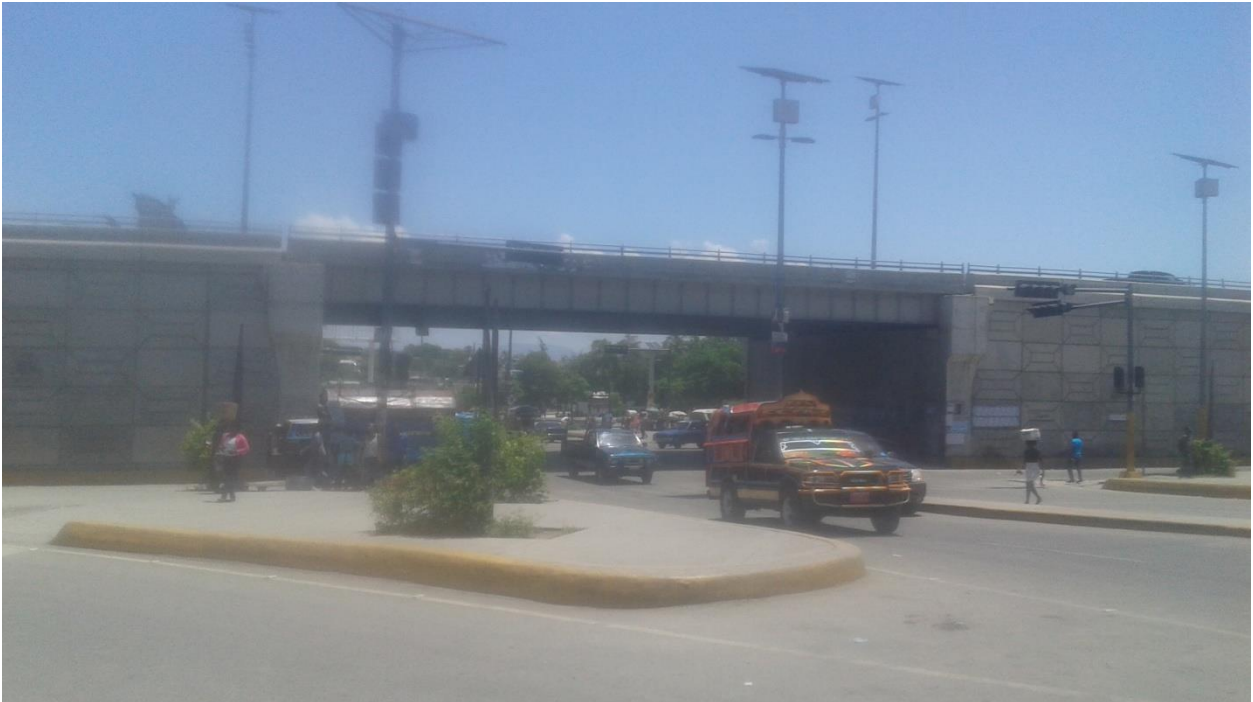
Viaduc de Delmas
