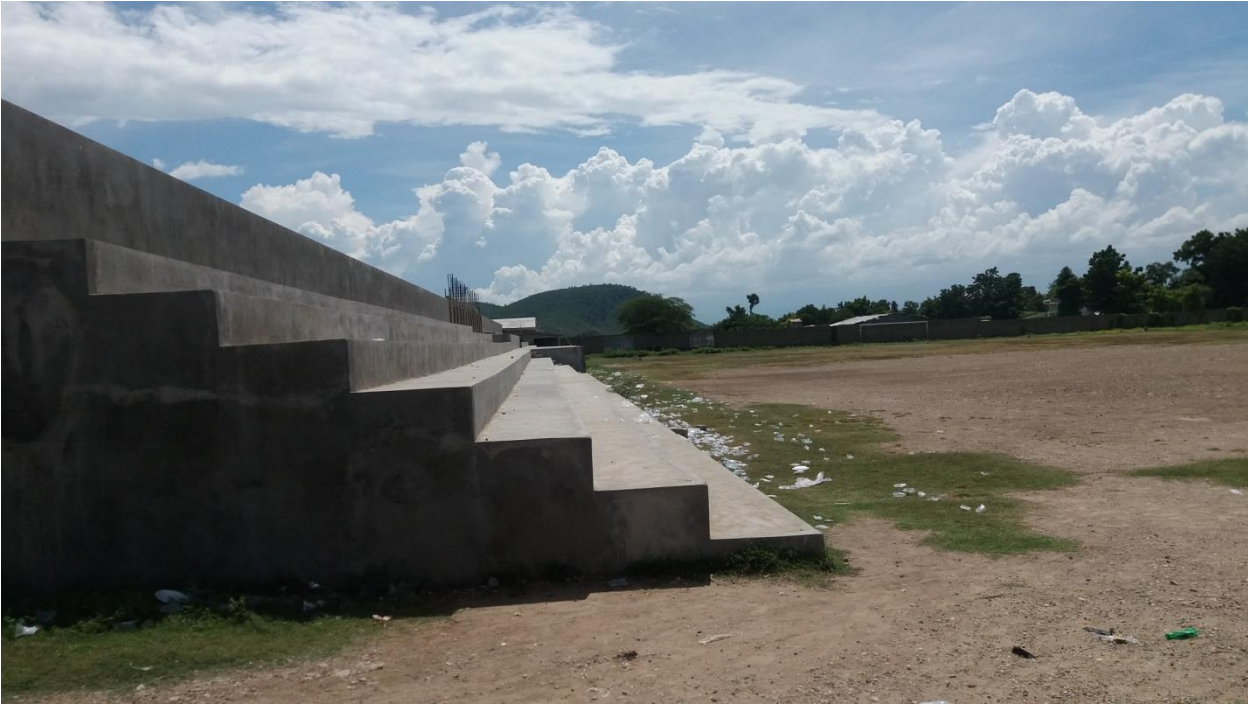
Partie de l'infrastructure construite du parc de Marchand
