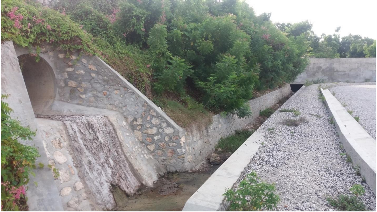
Drainage de la gare de Miragoâne
