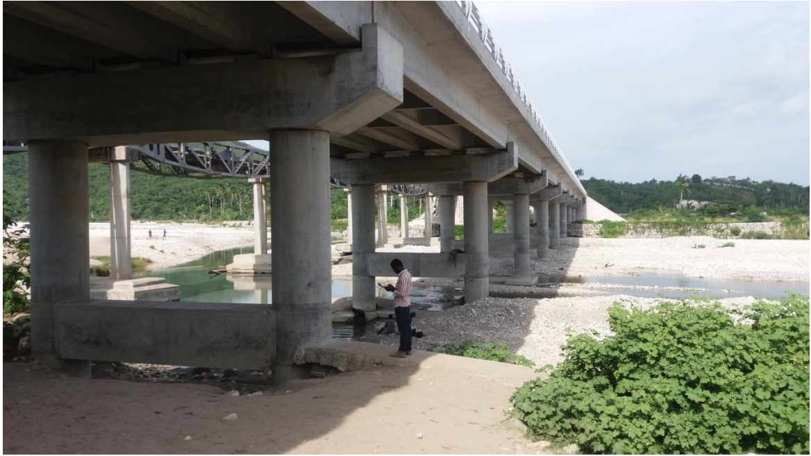
Infrastructure du pont Voldrogue
