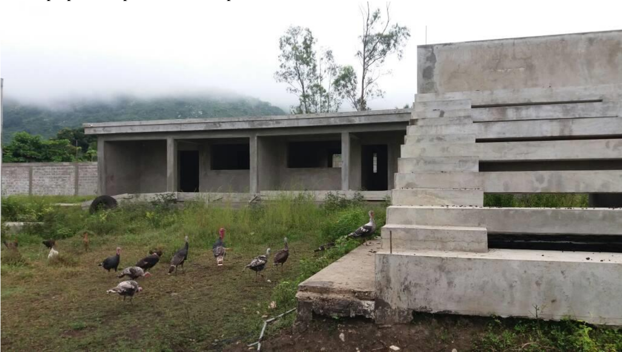
Infrastructure du centre sportif de Pignon
