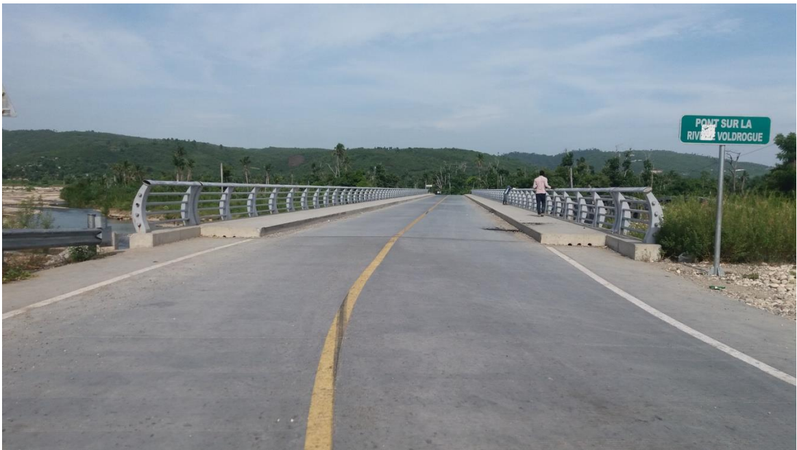
Entrée du pont Voldrogue
