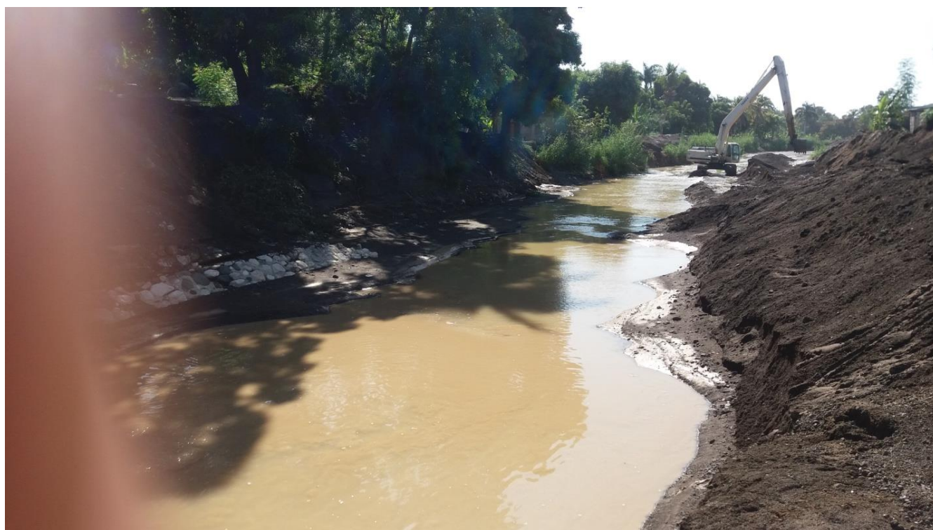
Dragage de la rivière en cours de réalisation
