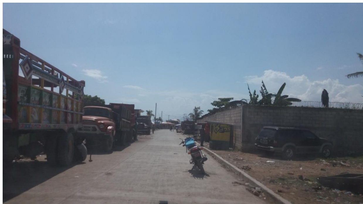
Vue d'une rue bétonnée inachevée
