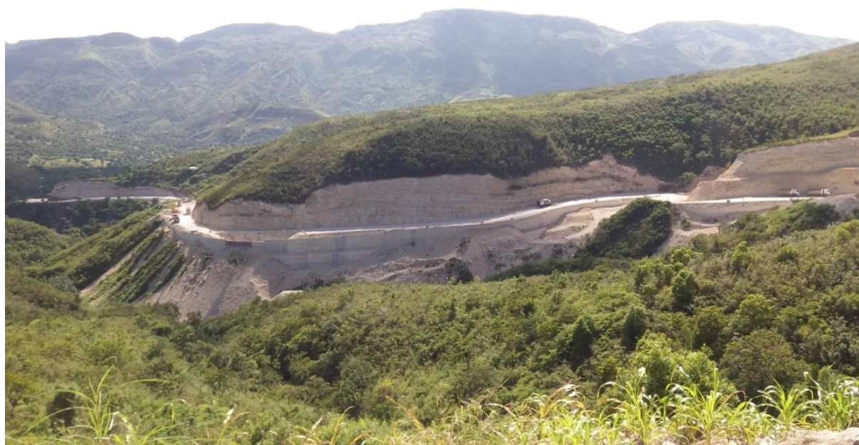
Travaux de terrassement du tronçon Ennery-Cap-Haitien, Pulboreau versant sud
