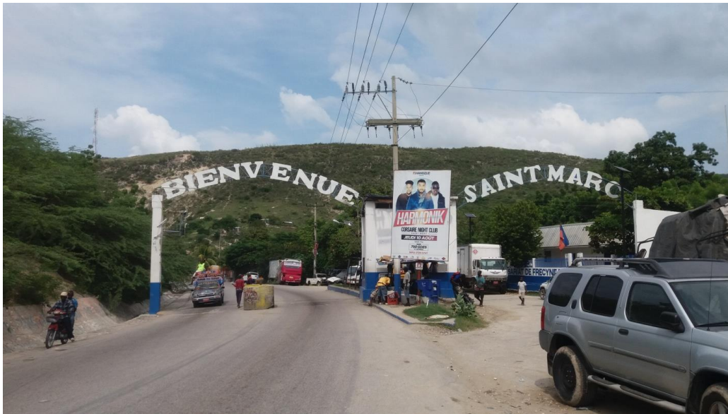
Réhabilitation de la route Frécyneau Saint-Marc
