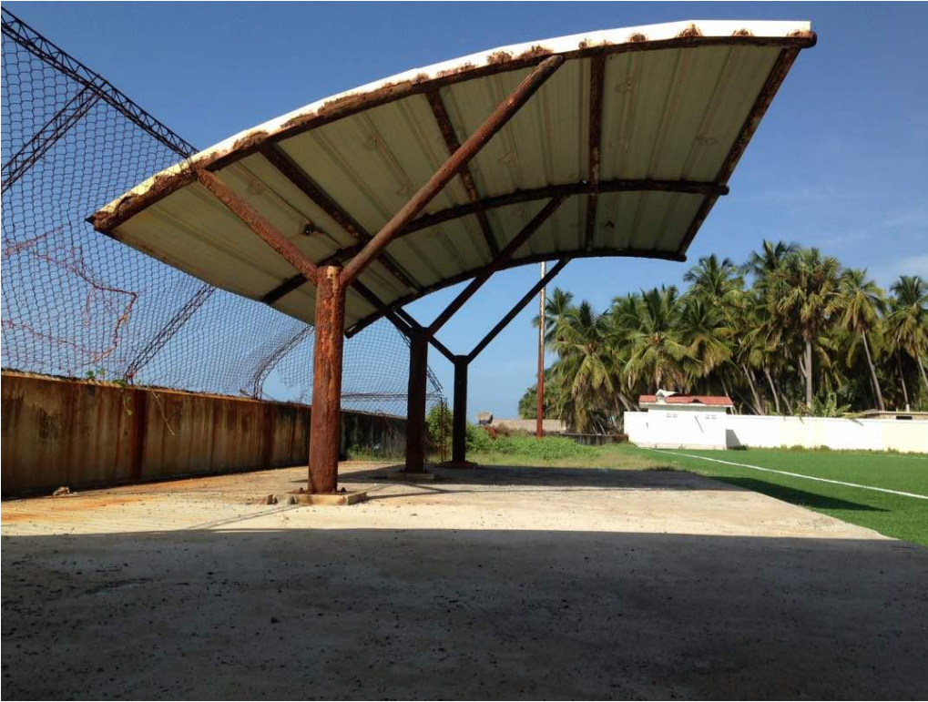
Installation des infrastructures du Centre sportif de Cayes-Jacmel
