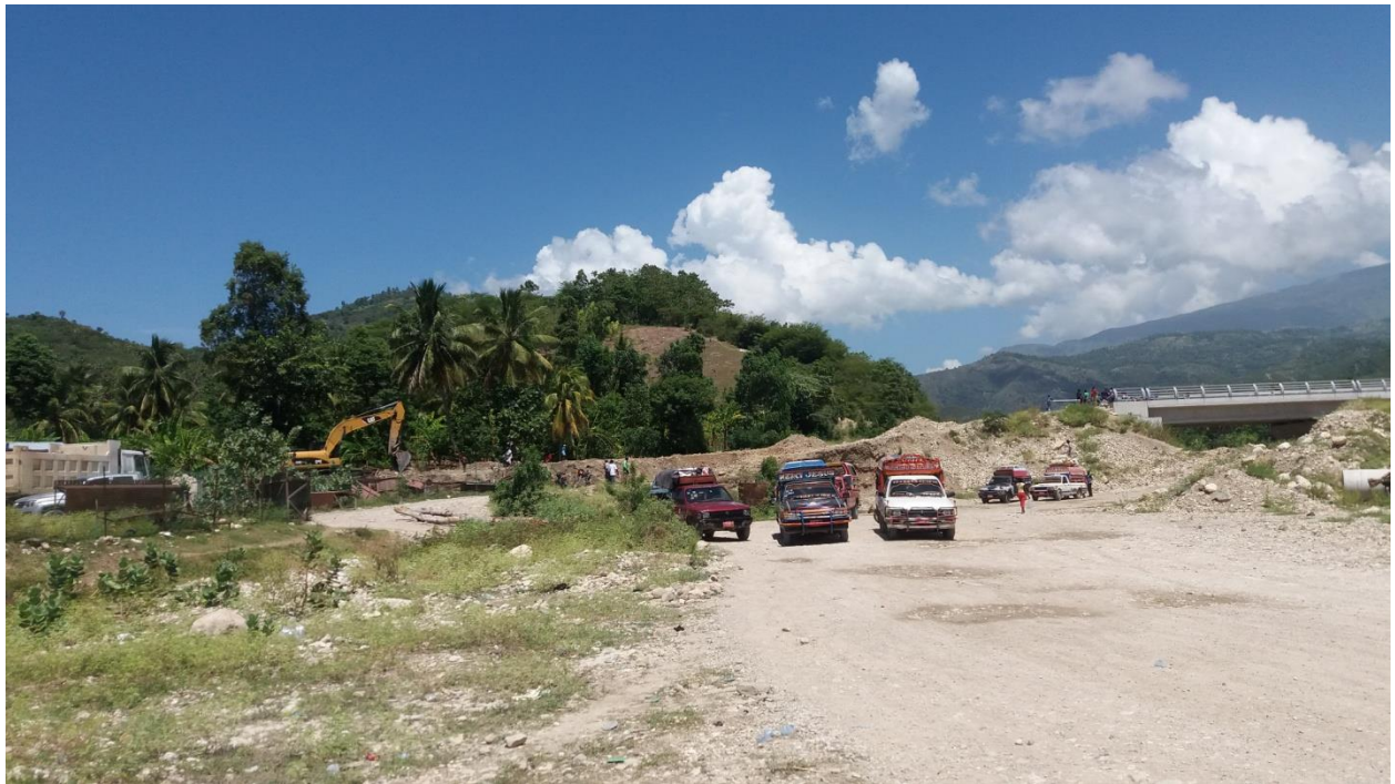
Les travaux de construction de la voie d'accès
