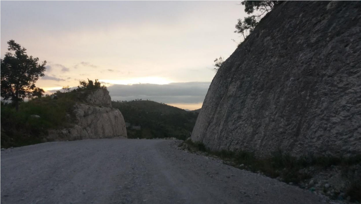
Terrassement de la partie restante
