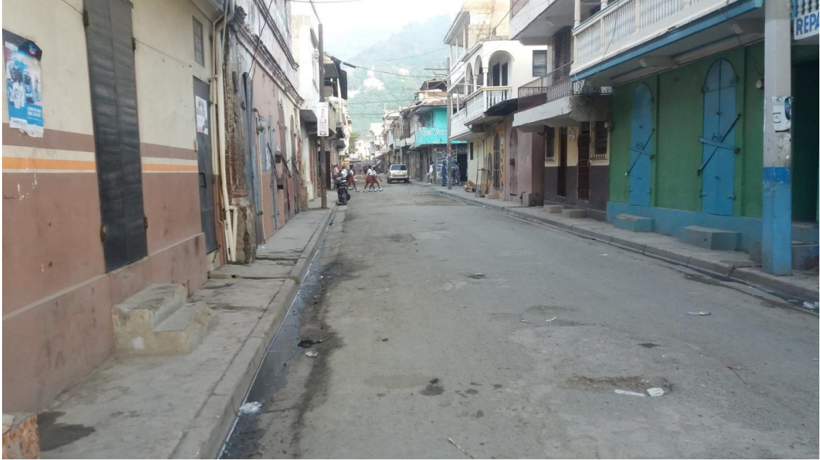
Etat de réhabilitation des rues du Cap-Haitien
