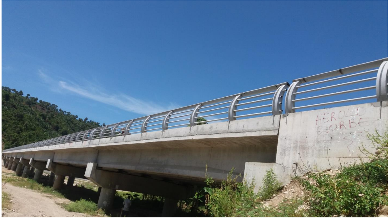
Le pont Péredo de profil
