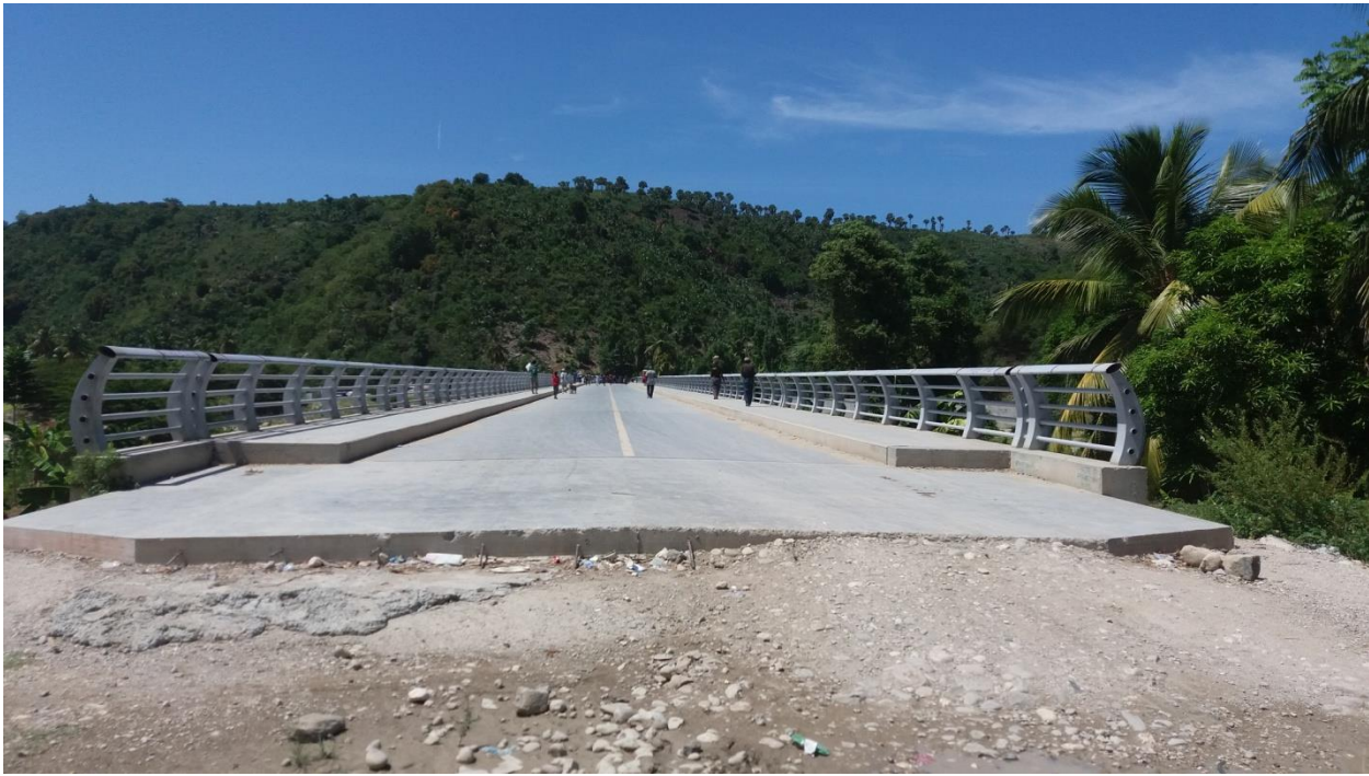
Le pont de Marigot (Péredo)
