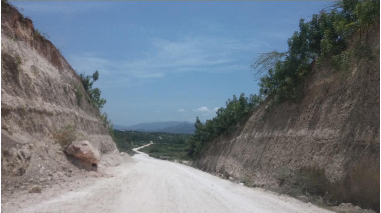
Travaux de terrassement du tronçon Petite-Rivière/Petit-Trou de Nippes
