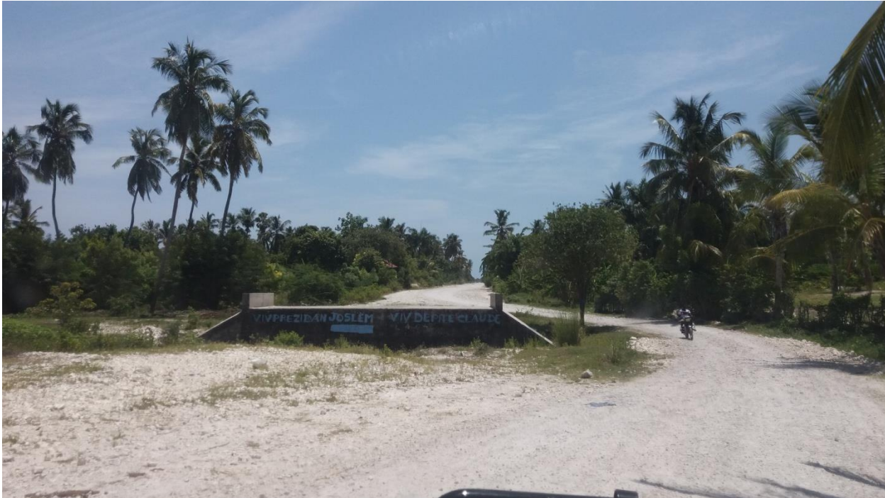
Dalot en construction non achevé du tronçon Petite-Rivière/Petit-Trou
