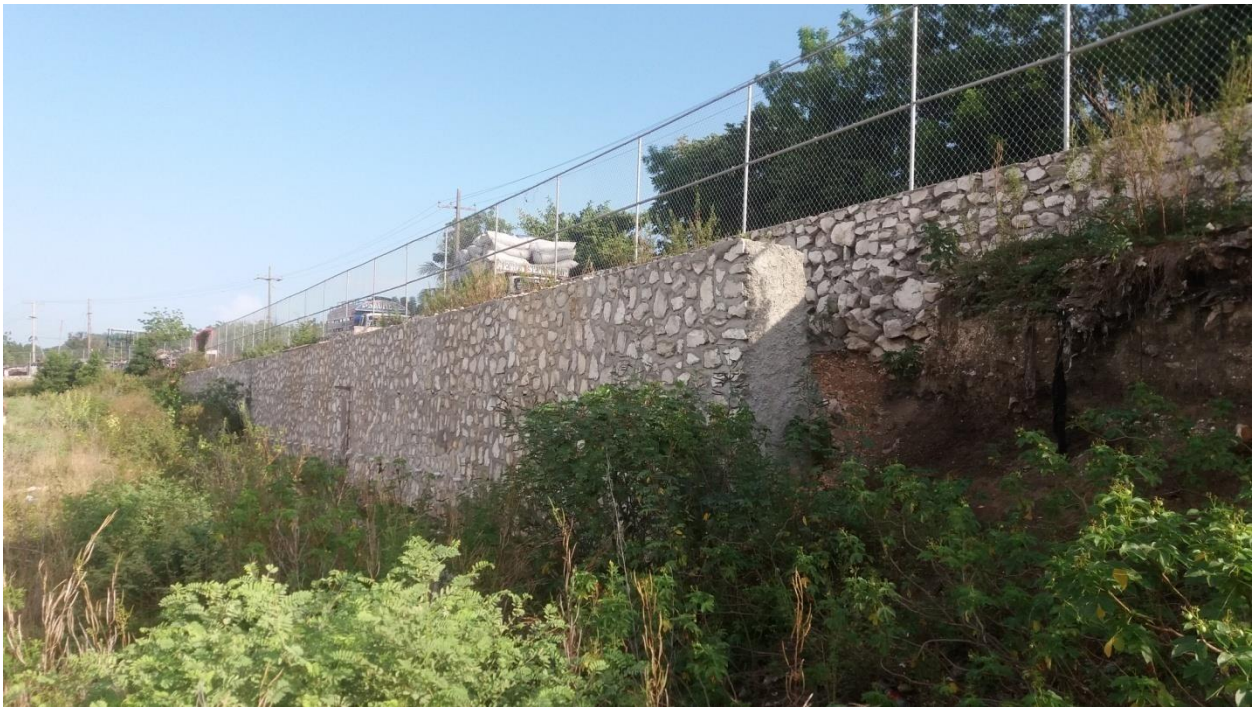
Mur de soutènement inachevé
