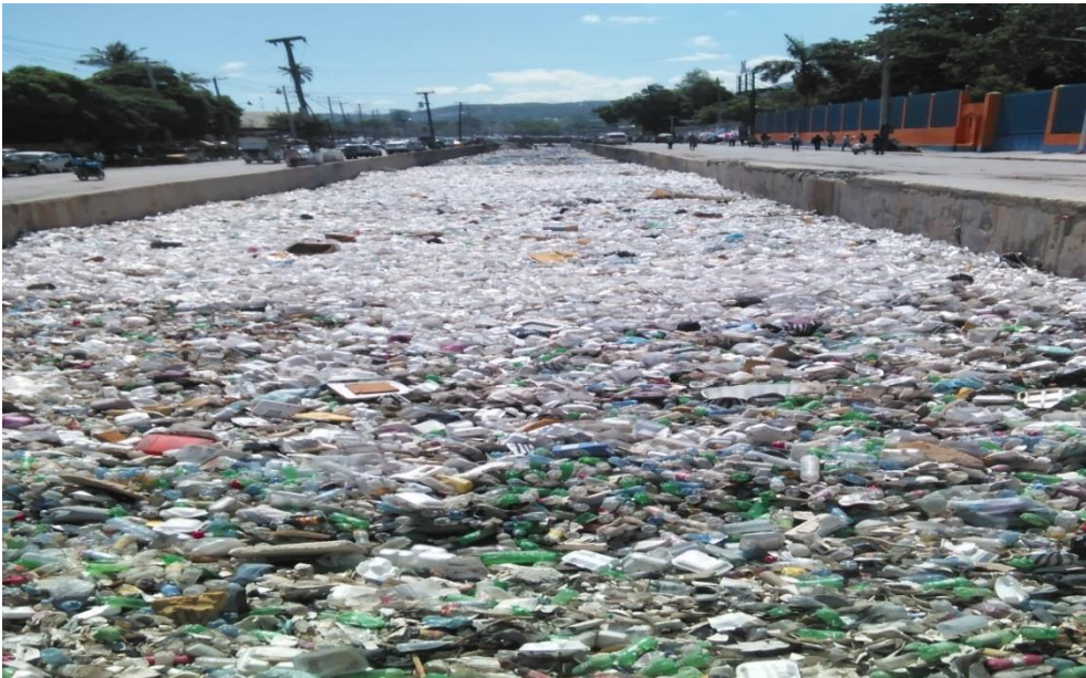
Etat d'un exutoire à ciel ouvert de Port-au-Prince
