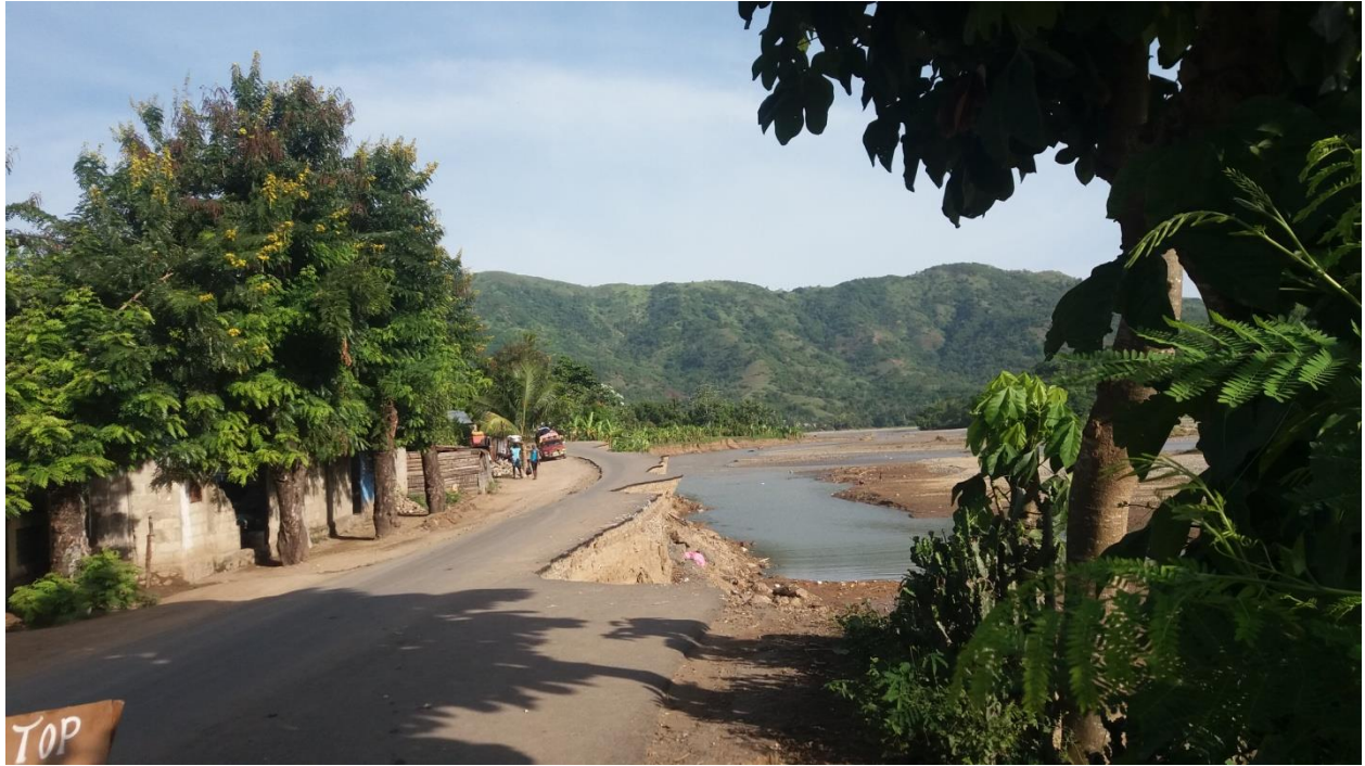
Effondrement de la route de l'entrée de la ville de la grande Rivière du Nord
