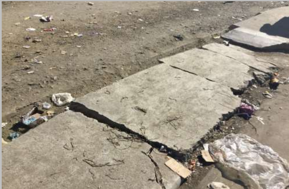
Rue CODEVI (trottoir) à Ouanaminthe
