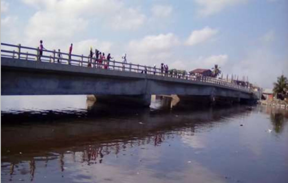
Pont à l'embouchure de la Rivière du Haut du Cap
